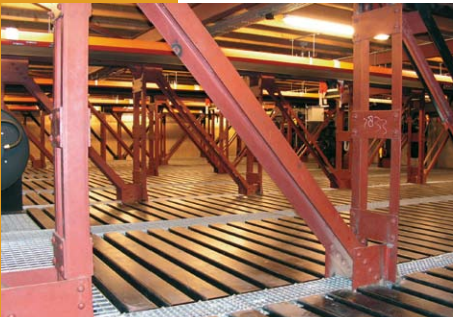
Lamellenvloer op de rollenzolder
